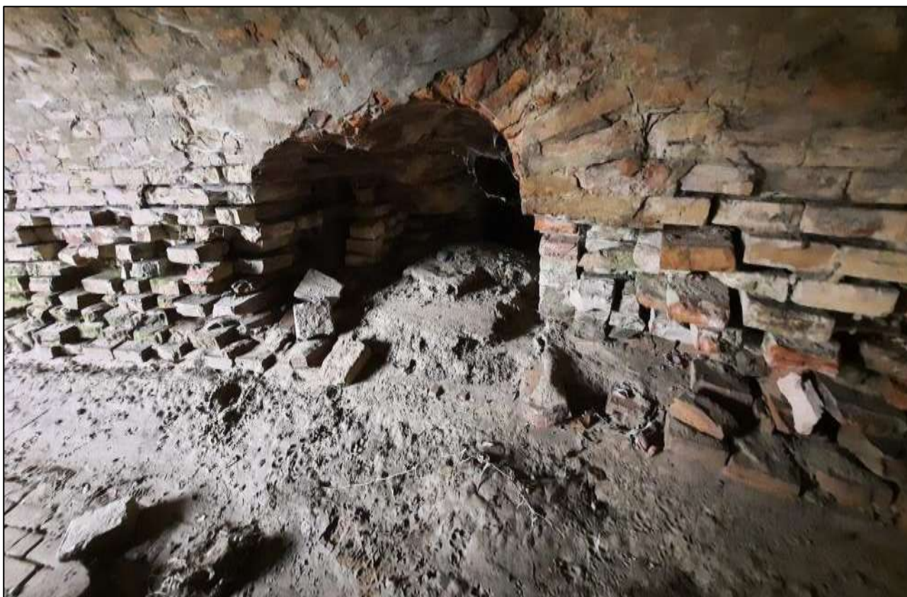
Figura 19: Dettaglio della volta in corrispondenza dell'immissione dello scolo Via di Budrio (cod. 066CV).
