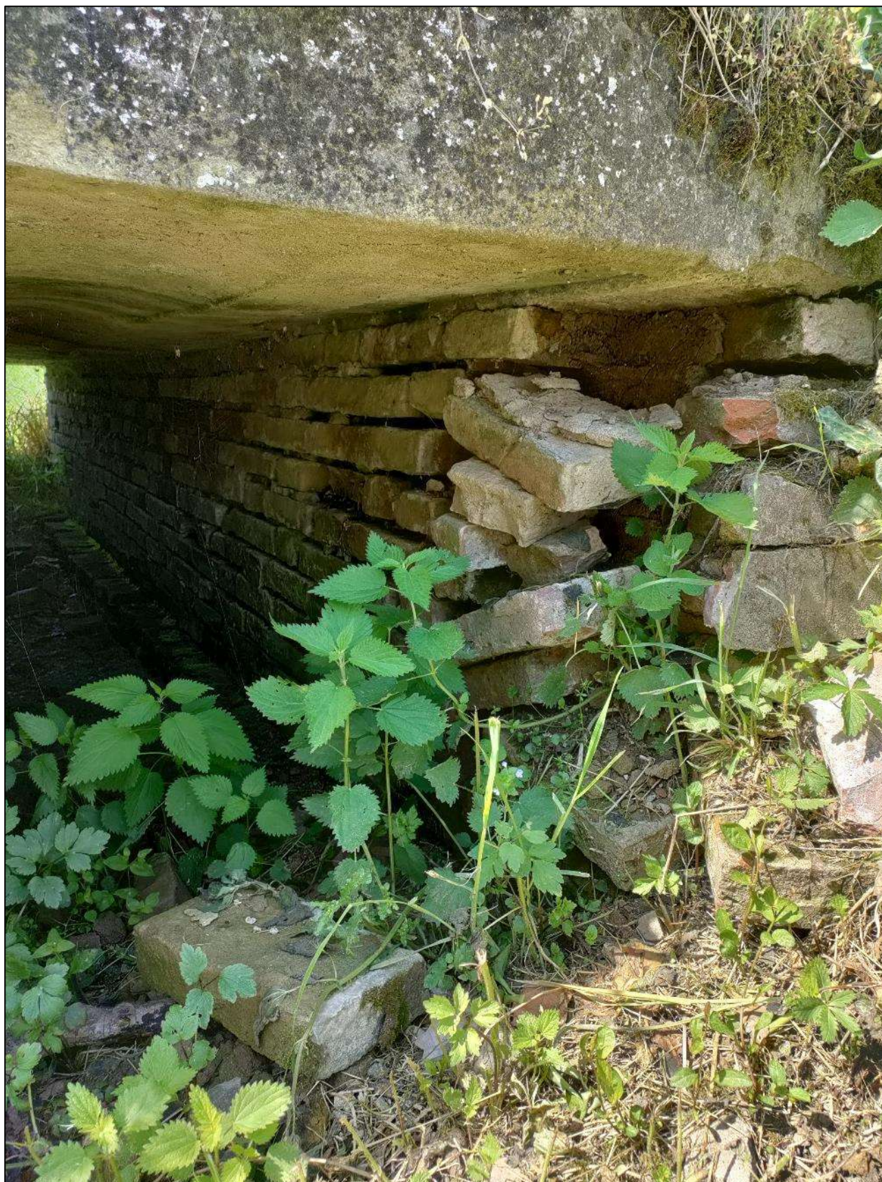
Figura 7: Dettaglio del punto maggiormente danneggiato.
