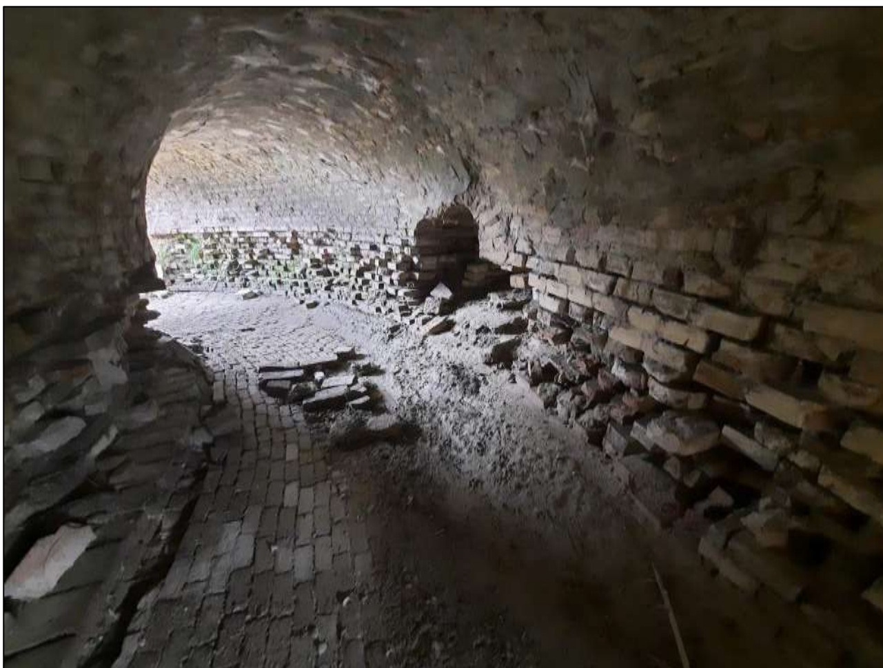
Figura 18: Vista della volta lato di destra idraulica, in prossimità dell'immissione dello scolo Via di Budrio (cod. 066CV).
