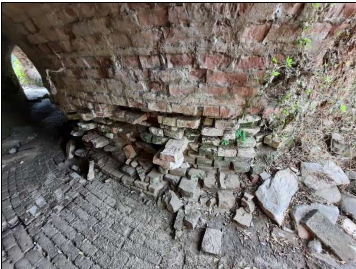
Figura 16: Vista della volta lato di sinistra idraulica, in corrispondenza del frontone di valle.
