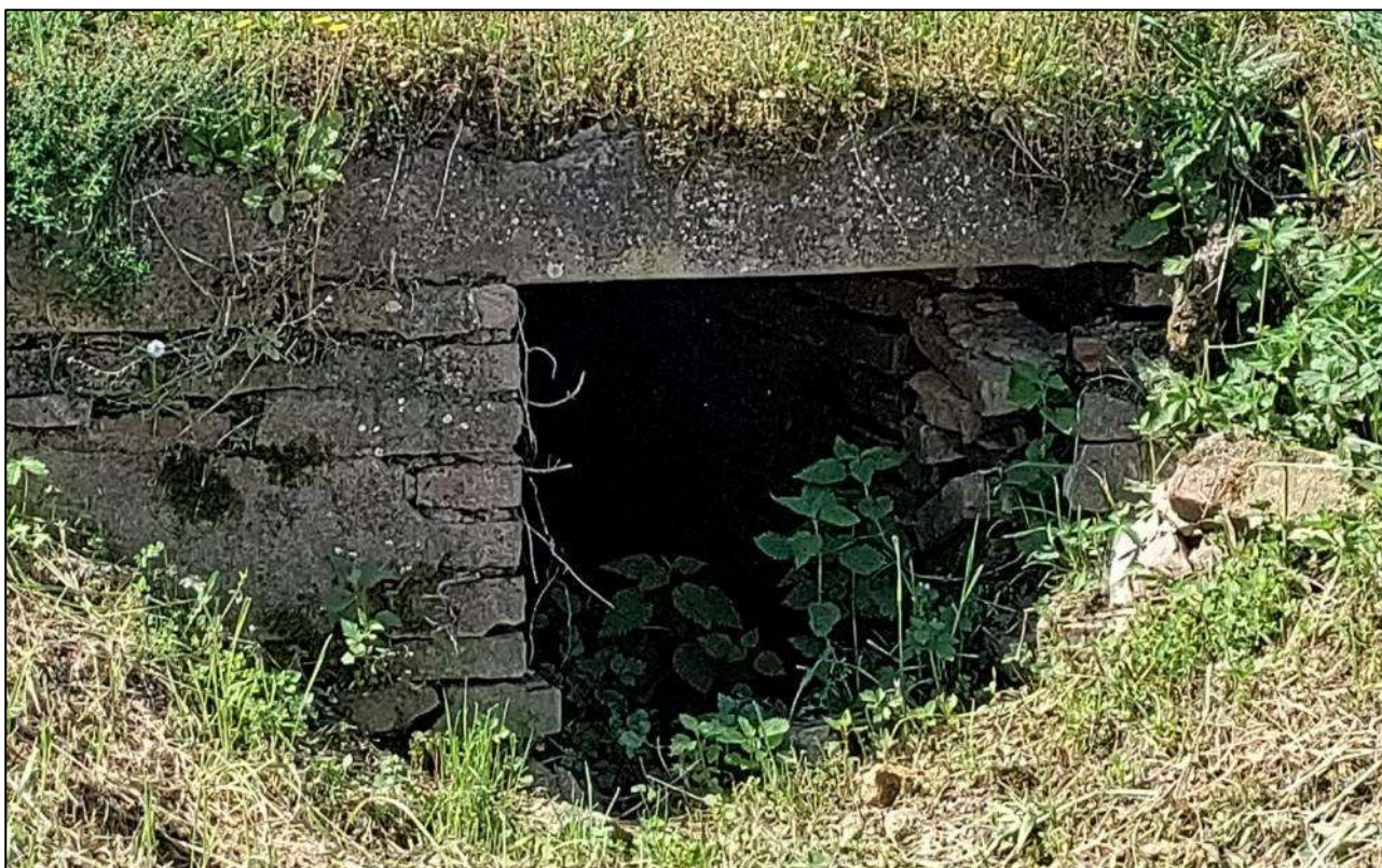
Figura 5: Vista del frontone di valle in cui è ben visibile il punto più ammalorato.
